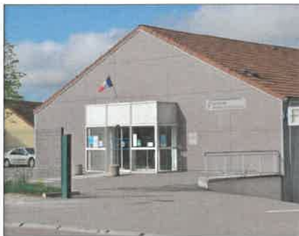
Le centre des impôts à Châtillon-sur-Seine. Photo LBP/FA. G.
