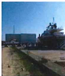
Le chantier Couach à Gujan-Mestras. ARCHIVE S. SO.
